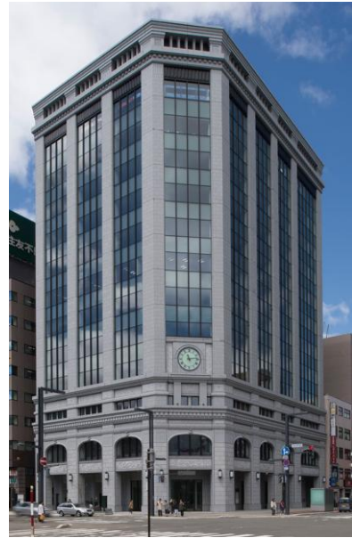
新札幌営業所の入居する札幌大通西4ビル
