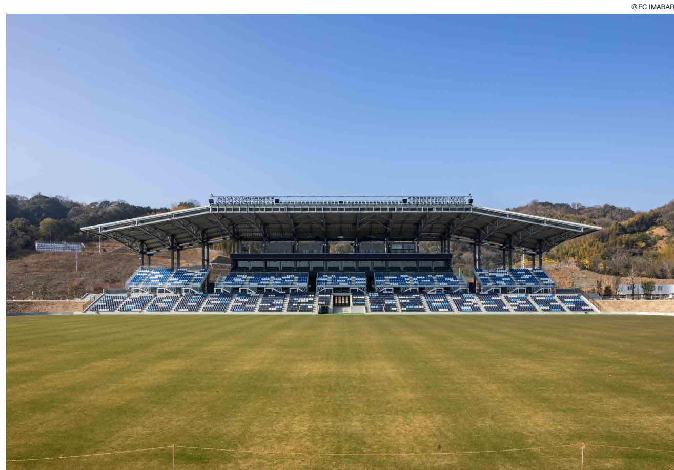
2023年1月に竣工した今治里山スタジアム
